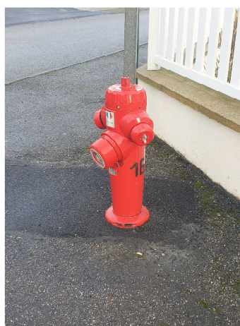
Pose de poteau incendie
