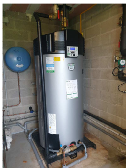
Remplacement de la chaudière Salle Bruno Legros
