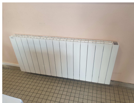
Remplacement des dalles chauffantes par des radiateurs électriques plus économiques
